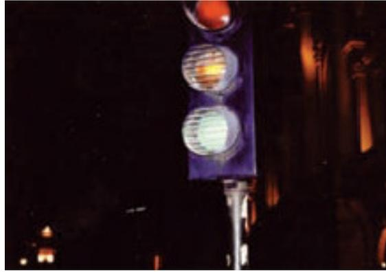
**Figura 7** – Dispositivo tipo persiana em grupo focal. Somente os condutores bem próximos do semáforo conseguem ver as indicações luminosas. **Fonte:** Londres.
