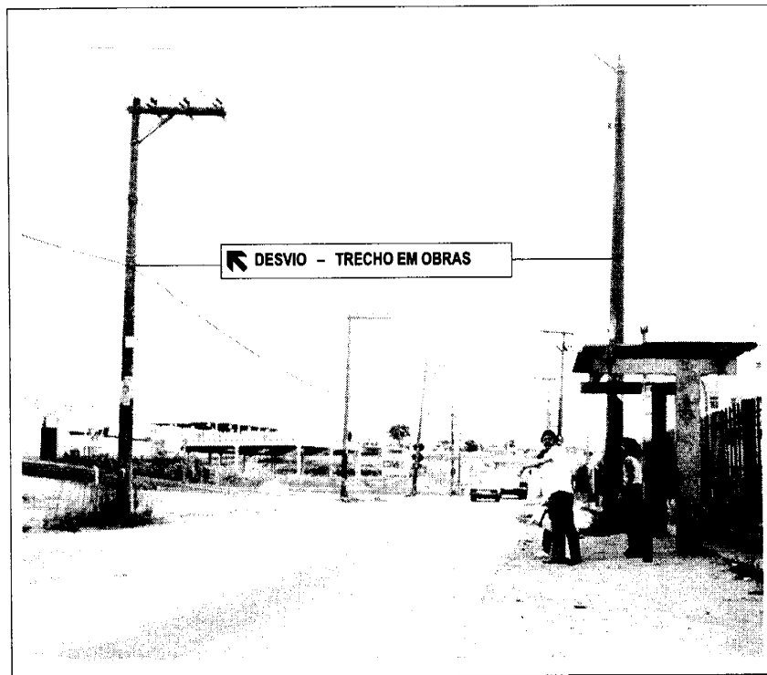
FIGURA 10.55 EXEMPLO DE SINALIZAÇÃO PROVISÓRIA AÉREA COM FAIXA DE PANO
