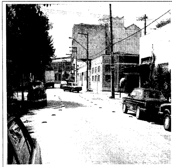
FIGURA 10.32 ESTREITAMENTO DA PISTA EFETUADO COM TACHÕES
