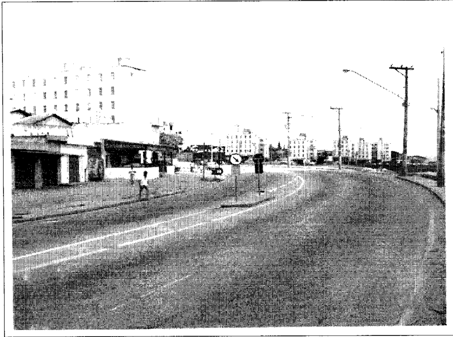
FIGURA 10.10 EXEMPLO DE REFUGIO DE CONCRETO AVENIDA SAPOPEMBA – SÃO PAULO
