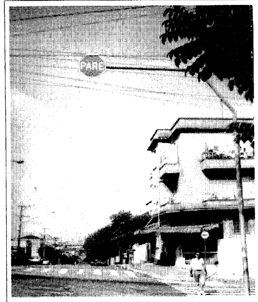
FIGURA 10.21 SINAL "PARE" EM BRAÇO PROJETADO RUA LINO COUTINHO x RUA LIMA E SILVA
